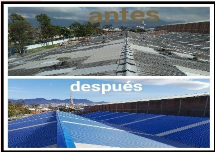
CAMBIO CUBIERTA QVALA
